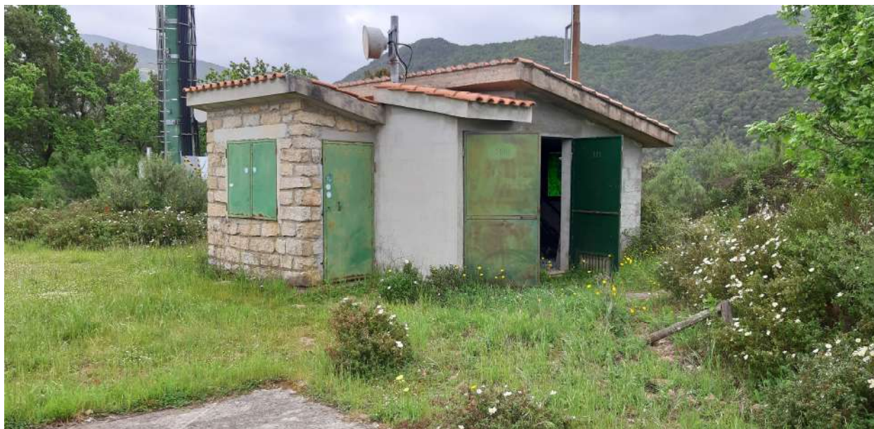
Intervento locale ripetitore loc. Ghennerilai
